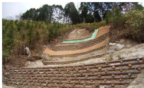
間伐材の型枠を使用した山腹工 〔岐阜県恵那市〕 中部森林管理局 東濃森林管理署
