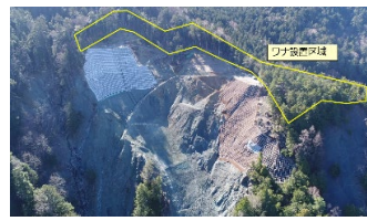
治山工事箇所周辺のワナ設置区域
