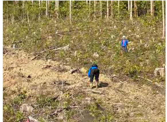
植栽列の標示作業（A 等高線区）
