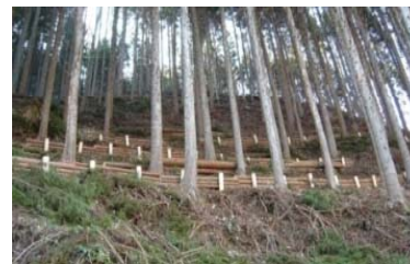
間伐木等を利用した簡易構造物の設置
