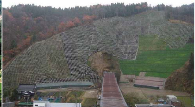
復旧状況 (平成18年11月)
