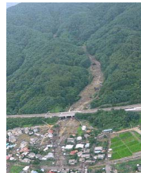
平成18年7月豪雨による災害 (長野県岡谷市)
