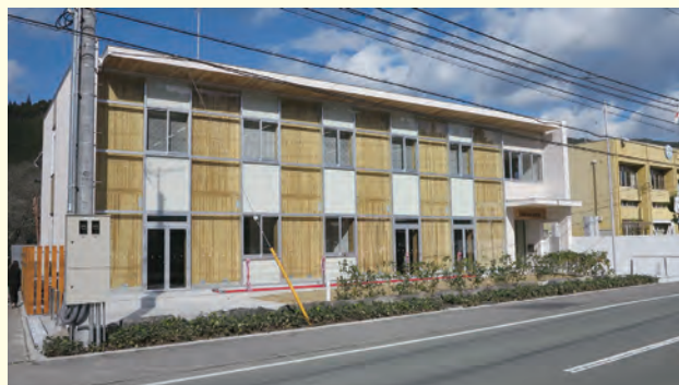
平成30(2018)年12月に完成した新庁舎
