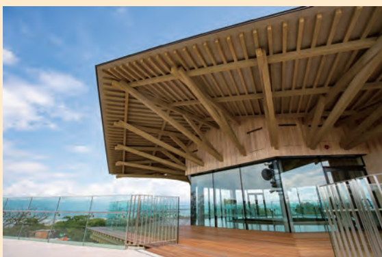
日本平夢テラス(静岡県静岡市)
