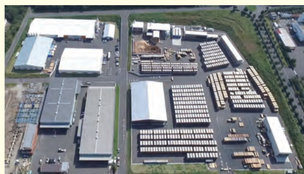
ツーバイフォー工法部材生産工場（鹿児島県霧島市）
