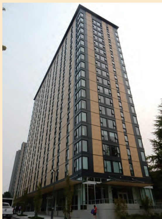
18階建ての学生寮「ブロックcommons」（2017年6月供用開始）
