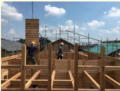
移築作業の様子
