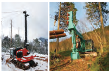
集材：タワーヤーダ等
