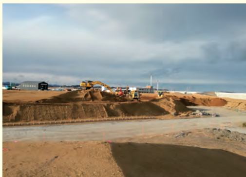
生育基盤盛土の造成風景
