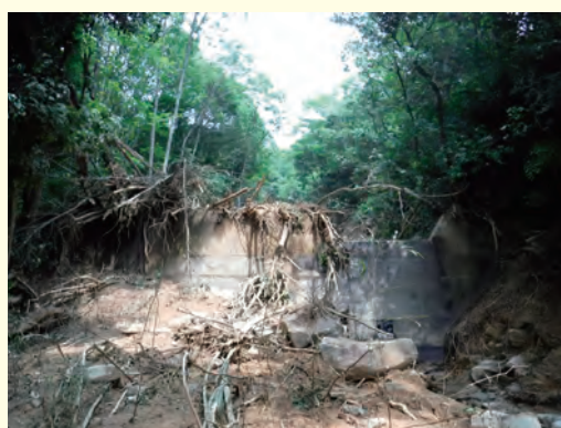
治山ダム(昭和42年度施工)による流木の流出等の抑制効果(岡山県笠岡市吉田地区)
