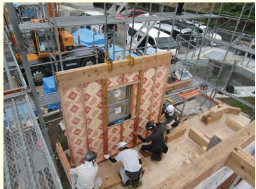
大型木造パネル住宅の施工の様子
