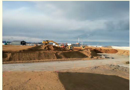
生育基盤盛土の造成風景
