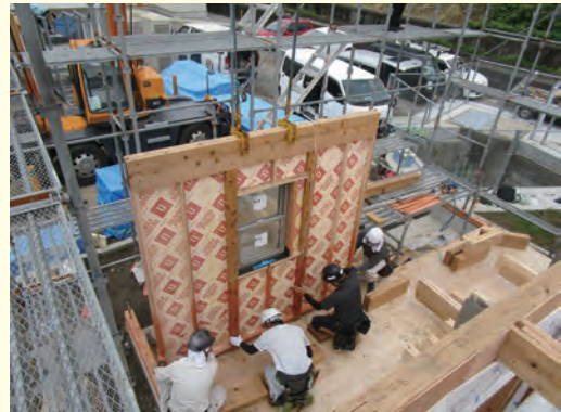
大型木造パネル住宅の施工の様子
