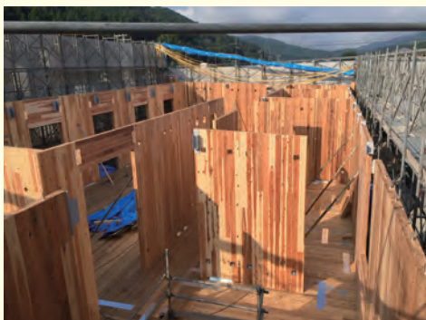
2階部分の建て方の様子
