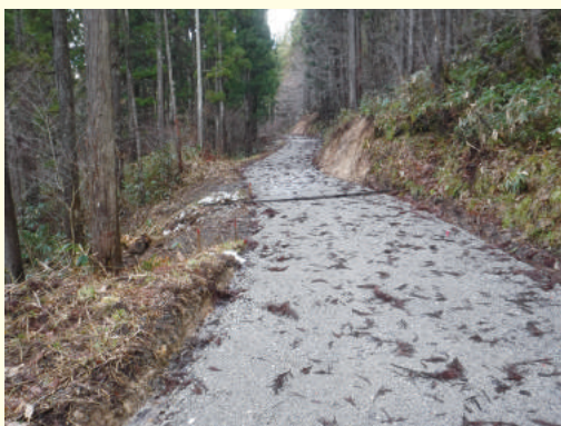
民有林に接続する作業道を開設
