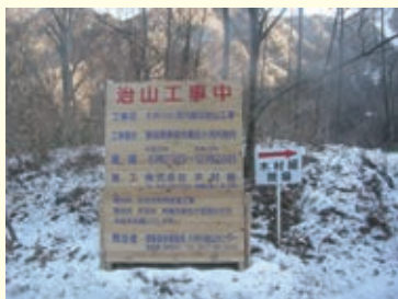
木製の工事看板
