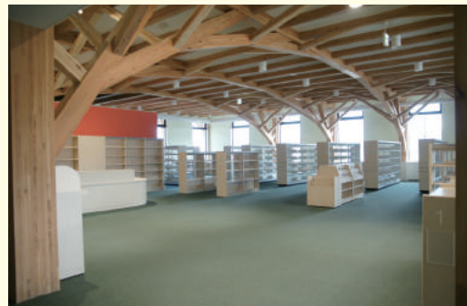
図書館の樹状方杖架構
