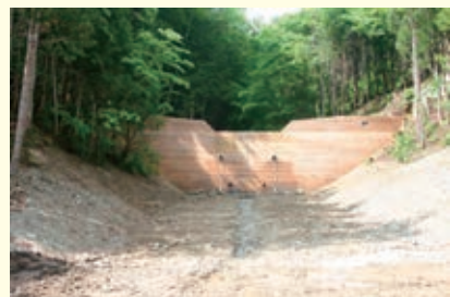
完成した治山ダム
