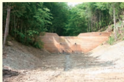
完成した治山ダム
