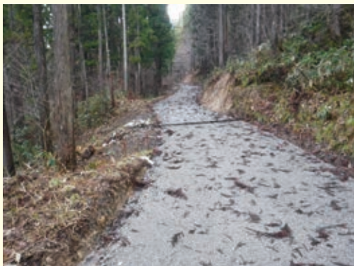
民有林に接続する作業道を開設
