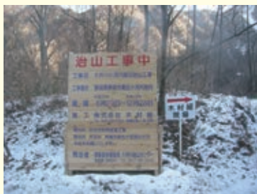
木製の工事看板
