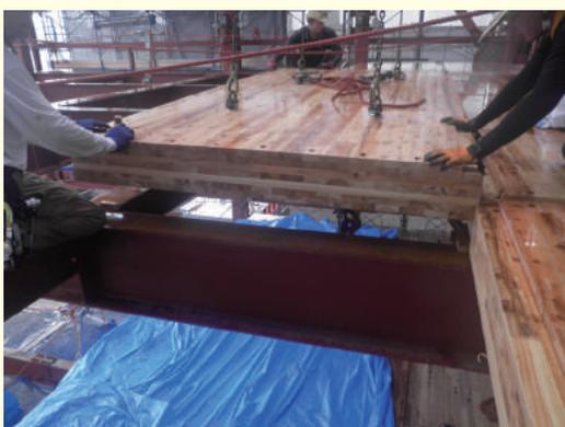
事務所棟のCLT床の施工の様子
