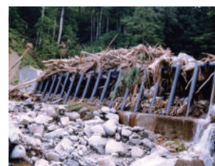
流木捕捉式治山ダムの設置
