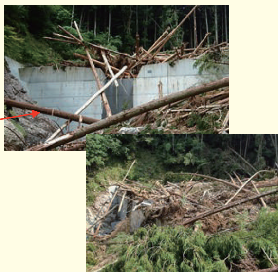
治山ダム(平成27(2015)年度施工)による流木の流出等の抑制効果 (福岡県朝倉郡東峰村猿喰地区)
