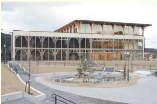
正面側の連続門型アーチ架構
