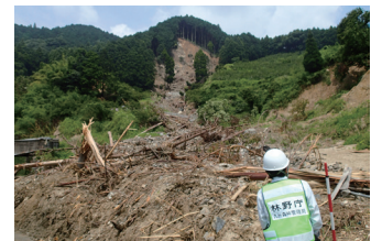
現地調査の様子
