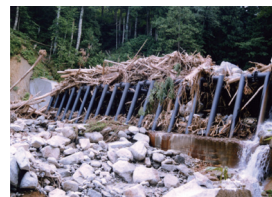
流木捕捉式治山ダム
