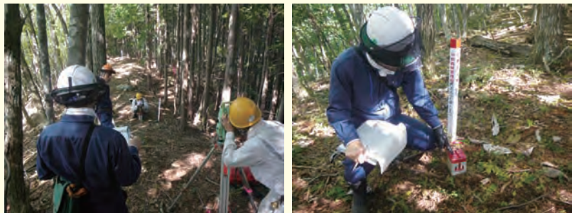
境界標の復元作業の様子
