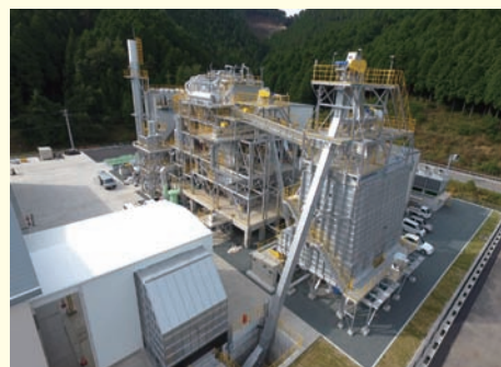
木質バイオマス発電所
