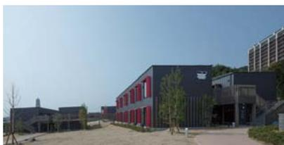
平成28(2016)年2月、長崎県佐世保市のテーマパーク内に、「CLTパネル工法」による木造2階建ての宿泊施設3棟が完成。客室内部は2面の壁をCLTの現しに。
