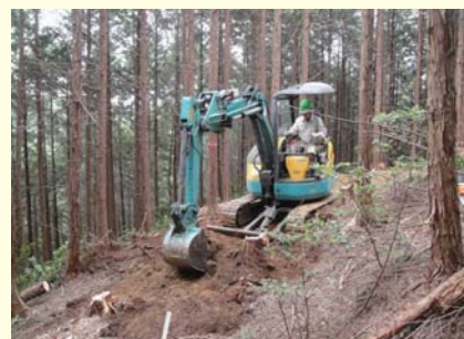
研修生による作業道開設の様子
