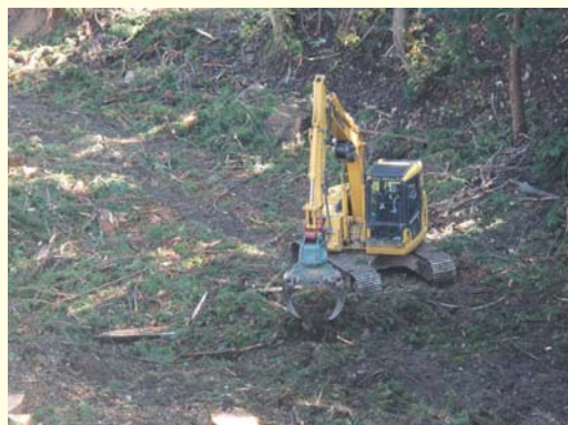
伐採と同時期に実施する地拵えの様子
