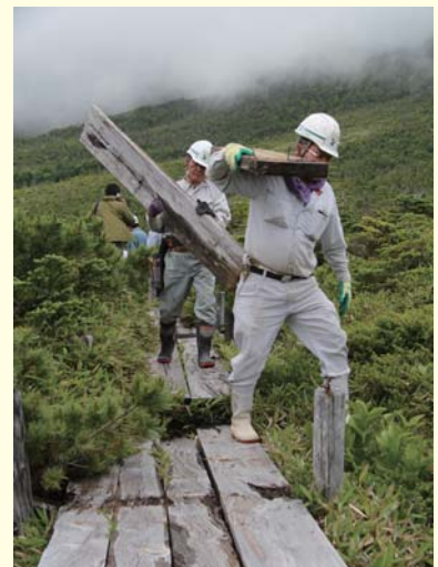
老朽化した木道の撤去の様子
