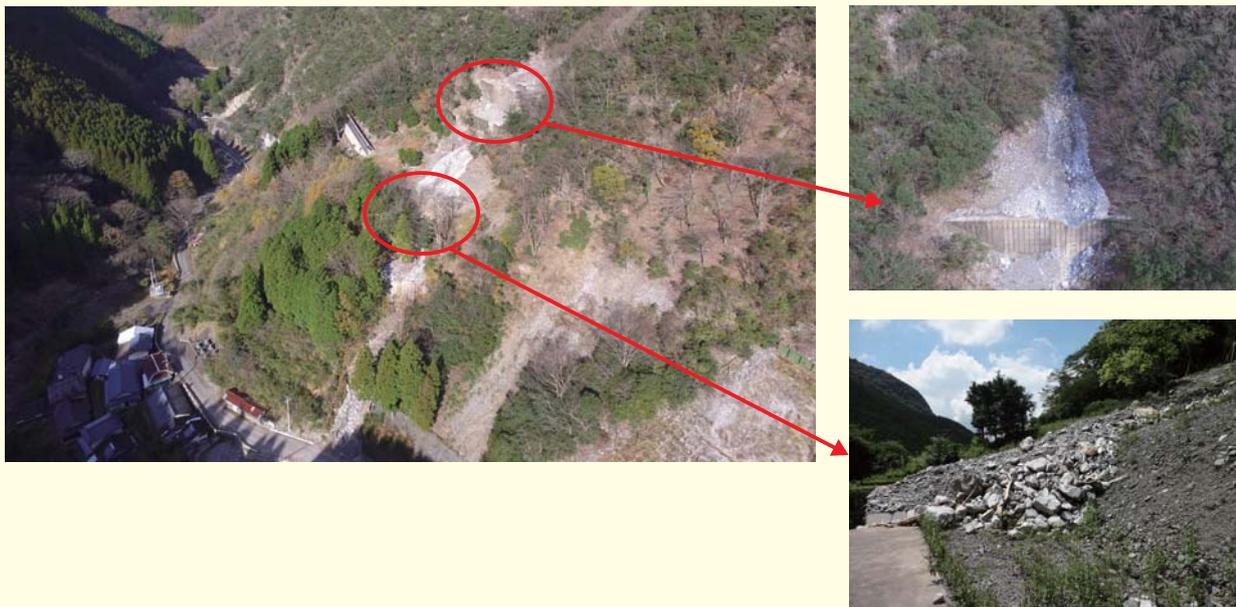
治山ダムによる土砂流出の抑制効果
