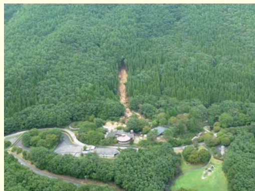
被害箇所の様子
