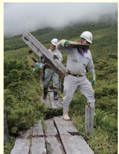
老朽化した木道の撤去の様子
