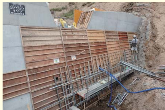
設置された国産材型枠用合板
