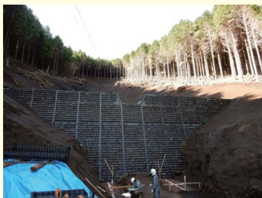
谷止工の施工状況(静岡県小山町)
