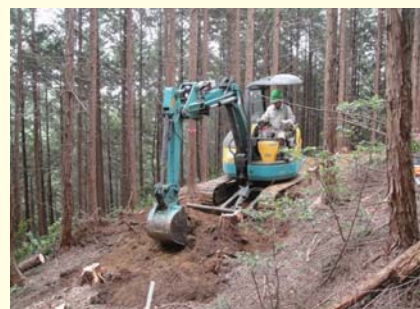
研修生による作業道開設の様子
