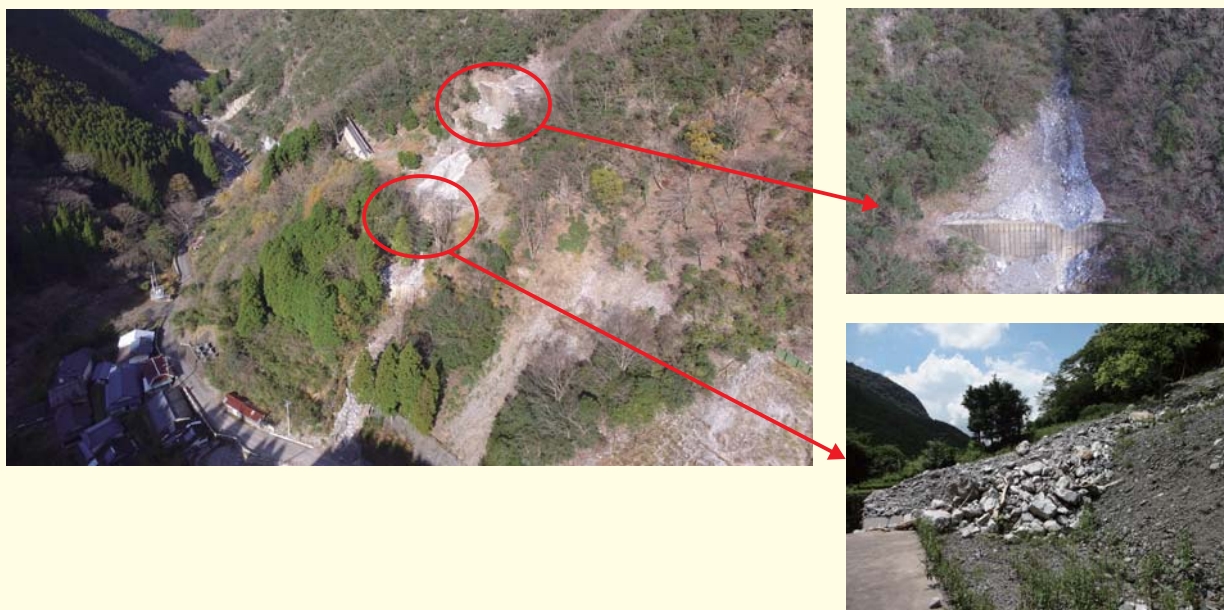
治山ダムによる土砂流出の抑制効果 (熊本県球磨郡五木村)
