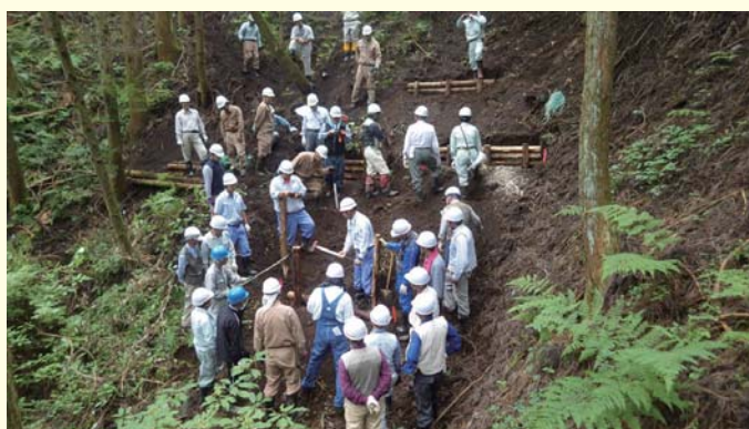
地域住民による木柵工の施工
