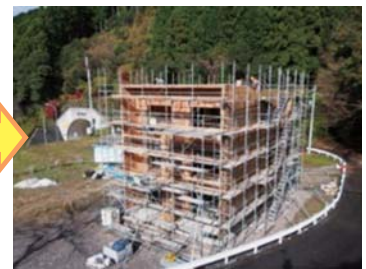
平成26(2014)年3月に高知県内で竣工したCLT建築物は、構造部分の建築が正味2日間で完了した。
