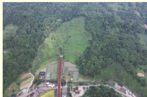
復旧状況(新潟県小千谷市)
