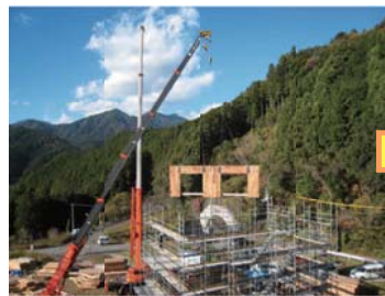
平成26(2014)年3月に高知県内で竣工したCLT建築物は、構造部分の建築が正味2日間で完了した。
