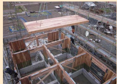
CLTで建設中の共同住宅(岡山県真庭市)
