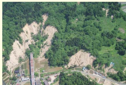
被災状況(新潟県小千谷市)
