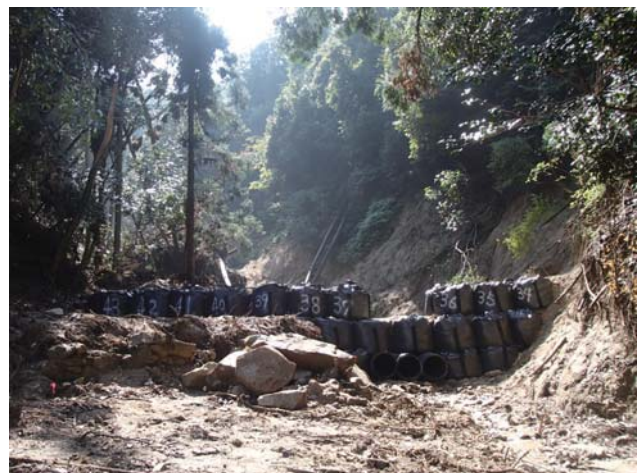
大型土嚢の設置による応急対策
