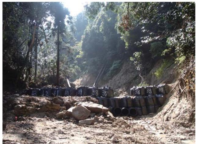
大型土嚢の設置による応急対策
