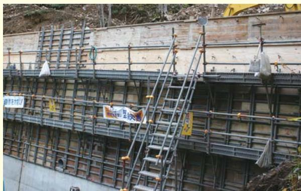
国産材型枠用合板の設置状況
