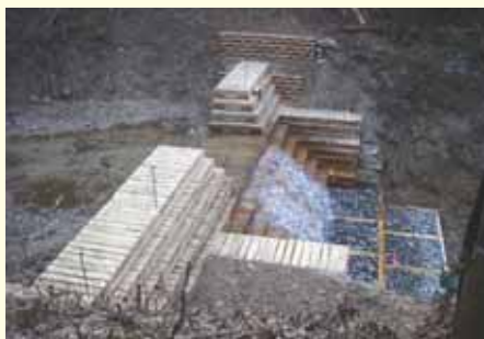
施工した木製治山ダム
