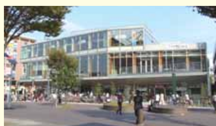
国内最大級の木造の商業施設
