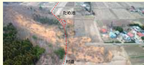
山腹崩壊の状況
