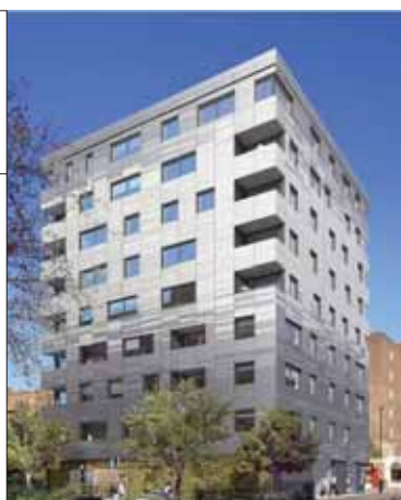
CLT を用いて建築された集合住宅（英国ロンドン） （木造9階建て。ただし、1階部分は鉄筋コンクリート造）
