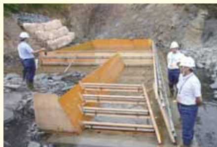
国産材型枠用合板の使用現場
