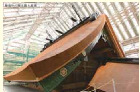
檜皮が葺かれた御本殿大屋根
