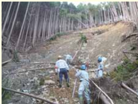
被害状況の調査(山口県萩市)
