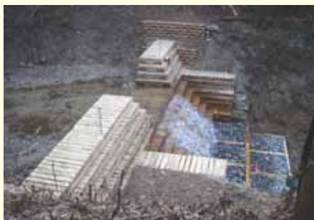
施工した木製治山ダム
