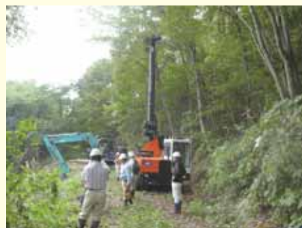
タワーヤーダを設置している様子
