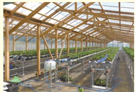
トラス型工法による農業用ハウス
