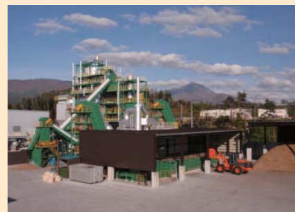
木質バイオマス発電施設の外観(福島県会津若松市)
