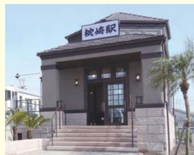
枕崎駅舎の外観
