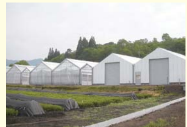
コンテナ苗生産施設の外観
