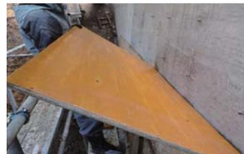
国産材針葉樹を原料とするコンクリート型枠用合板
