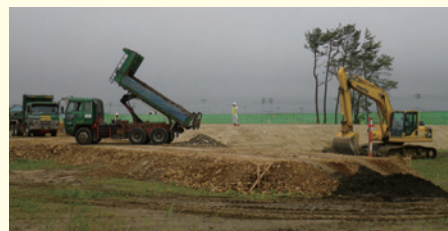
仙台市荒浜地区の盛土工事の施工状況
