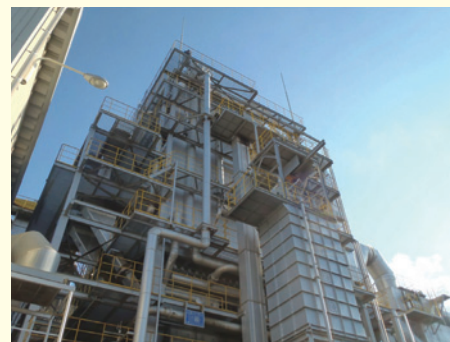
木質系災害廃棄物を発電燃料に活用している バイオマス発電所
