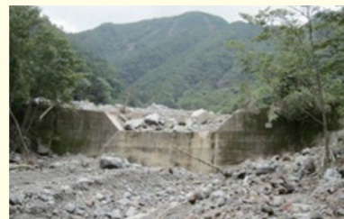
治山堰堤における溪床の固定効果 (熊本県阿蘇市)
