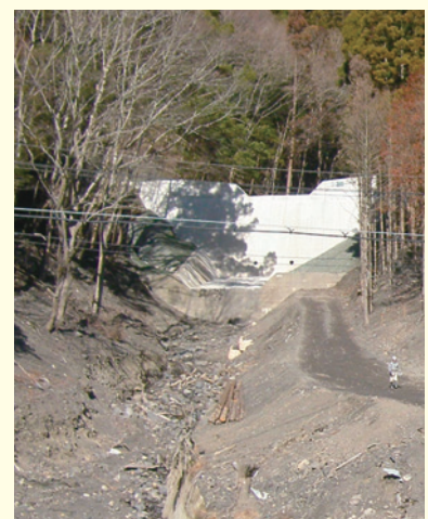
荒廃溪流の復旧状況 （奈良県十津川村）
