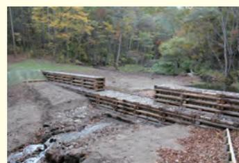
写真：間伐材を利用した木製床固工
