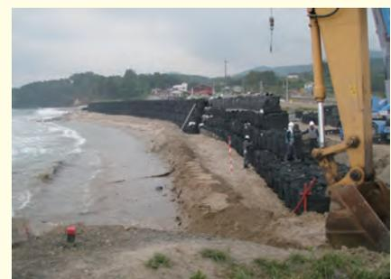
大型土のうによる緊急対策工事
