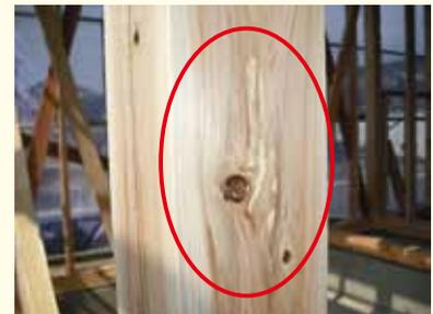
構造材として使用されたあかね材(丸囲い部分が食痕箇所)
