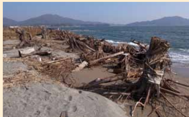
被災後の状況
