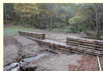
写真：間伐材を利用した木製床固工
