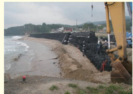
大型土のうによる緊急対策工事
