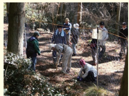
シカ防護柵の設置
