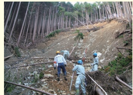
被災状況の調査
