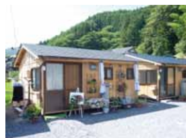
岩手県住田町 すみたちょう による木造仮設住宅
