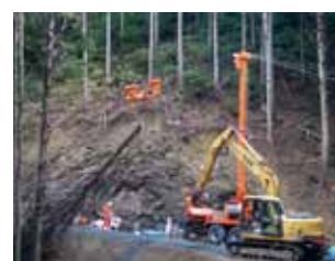
新たに導入したオーストリア製の タワーヤーダーと搬器
