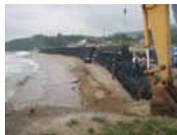
大型土のうによる緊急対策工事
