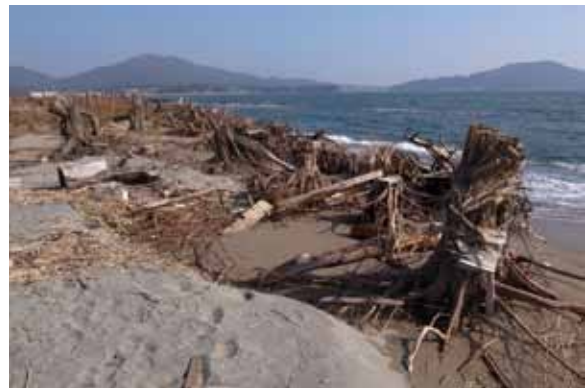
被災後の状況
