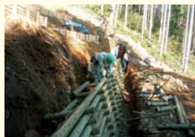
間伐材を利用した丸太積土留工
