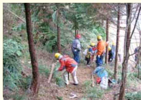
隊員による歩道修理
