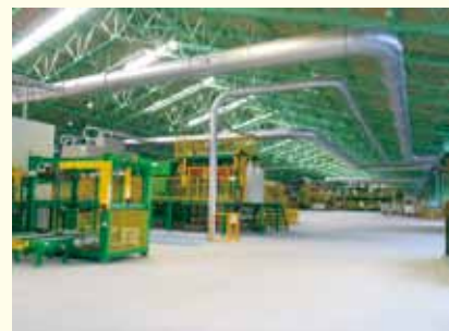
合板工場内部
