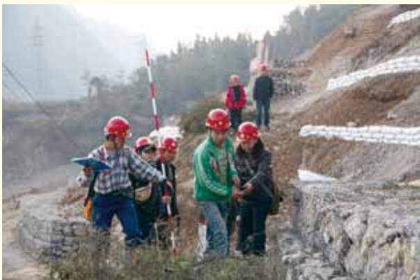
治山工事の完成検査を行う治山専門家
