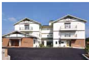
岡山県玉野市の特別養護老人ホーム。国内最大級の在来工法による木造耐火建築物。
