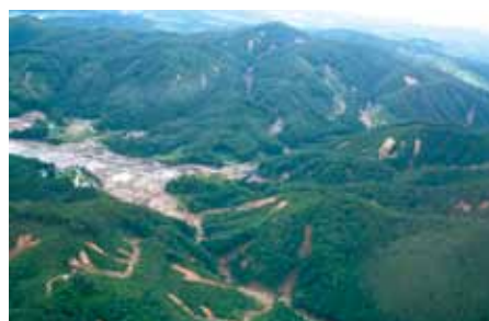
平成22(2010)年に発生した山地災害
