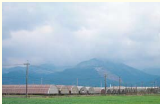
木質バイオマス利用ボイラーを導入した養鰻場
