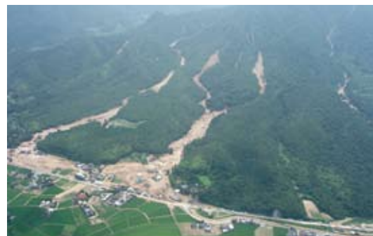
平成21(2009)年7月 中国・九州北部豪雨による被害(山口県防府市)
